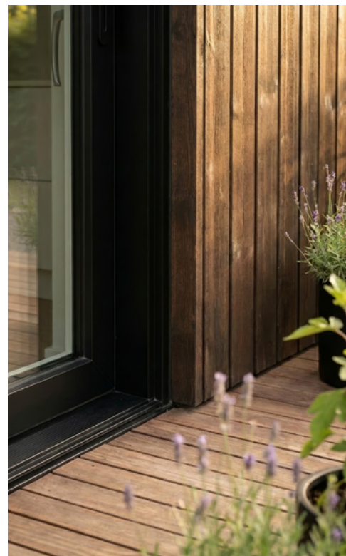
RENT UTTRYKK: Kledningen uten synlig innfestning gir et mye renere og eksklusivt uttrykk på fasaden.
