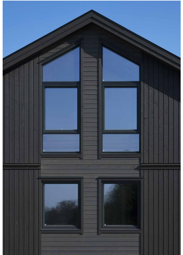
KOMBINERT Selbuhus med kombinert liggende og stående kledning for et spennende uttrykk.
