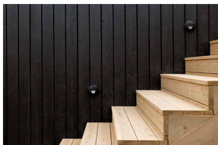
GJENNOMTENKT HELHET: Skreddersydde plantekasser med dobbelfals kledning og trapper i tre forsterker helheten på uterommet.
