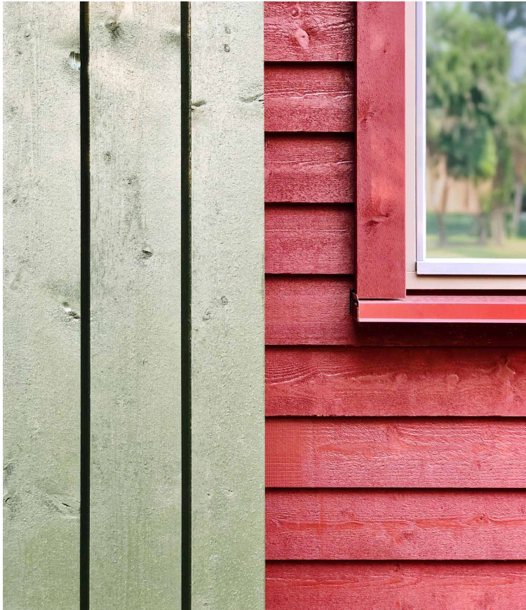
SKILLE 2-mannsbolig i Thaulowbakken hvor enhetene har ulik kledning og farge.
