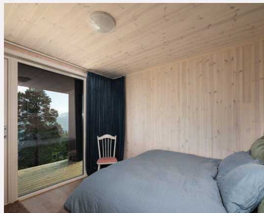
Vegg / tak: Kalkvoks
