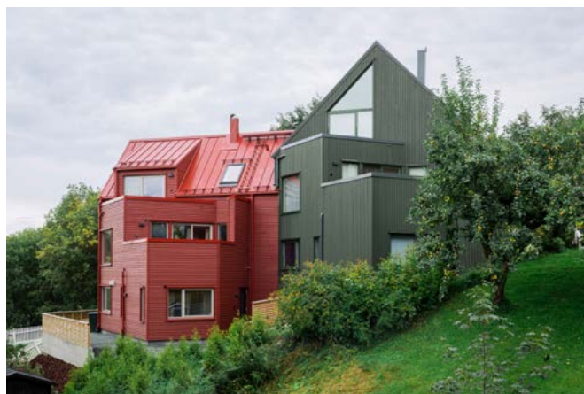
Thaulowbakken 1 ferdig bygd. Foto: SPARK Studio
